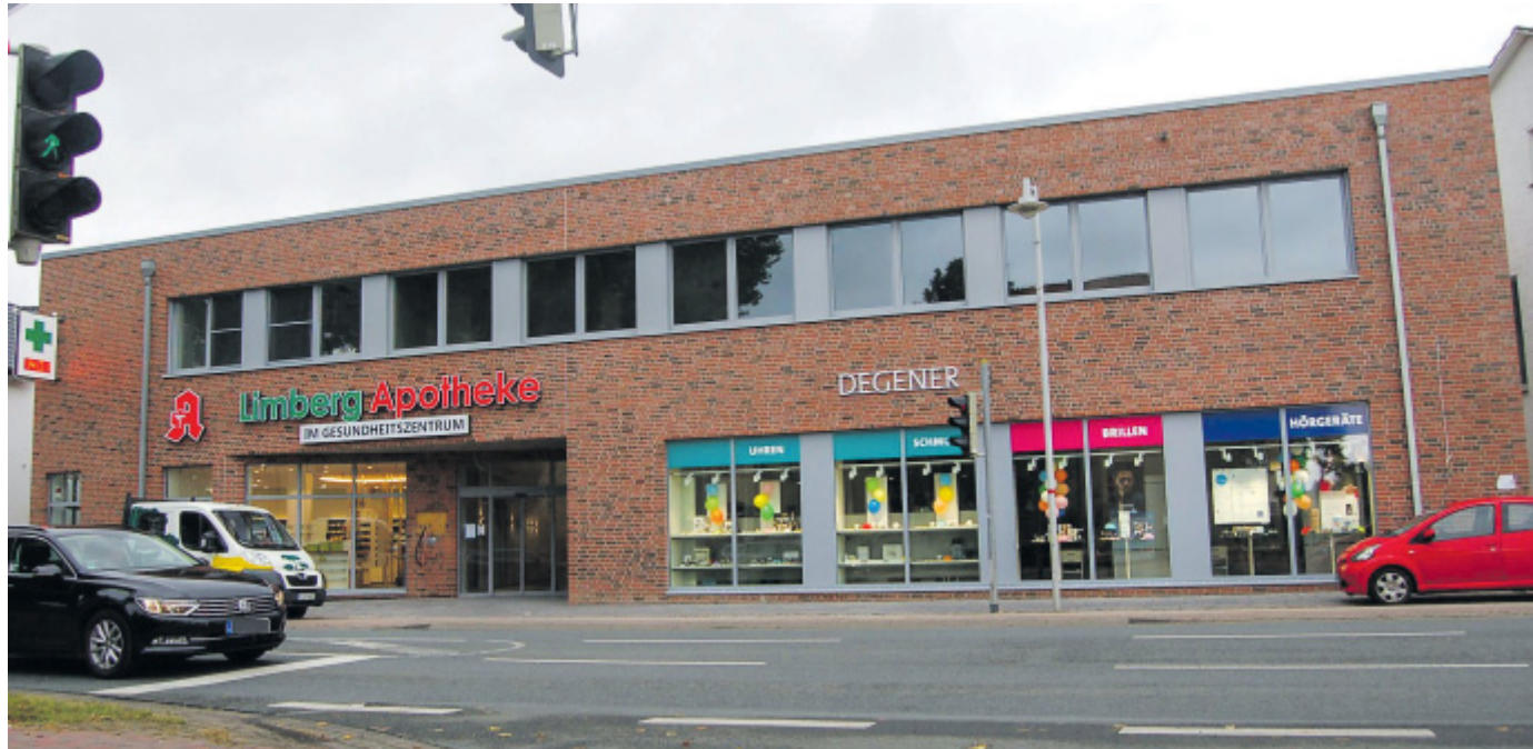
Moderne Architektur, kurze Wege: Direkt an der Mindener Straße in der neuen Stadtmitte befindet sich das Gesundheitszentrum. FOTOS: SPIEKER
