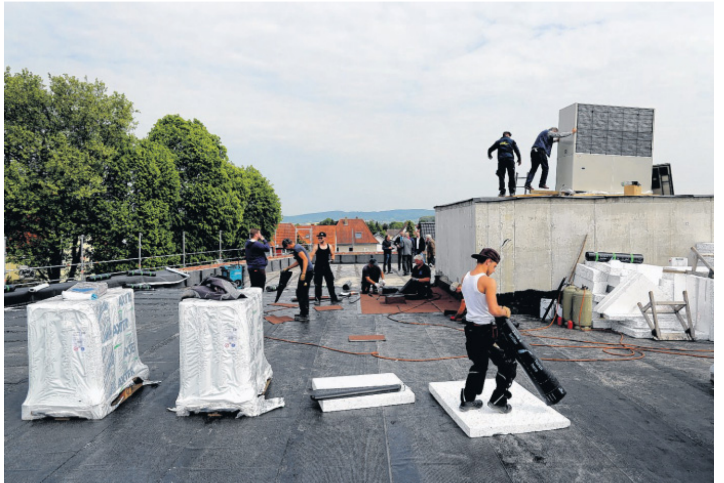
Deckenfest unten, reichlich Arbeit weiter oben: Auf dem Flachdach waren gestern ein halbes Dutzend Arbeiter damit beschäftigt, die Fläche mit Styropor und Teerpappe abzudichten. FOTOS: TYLER LARKIN
